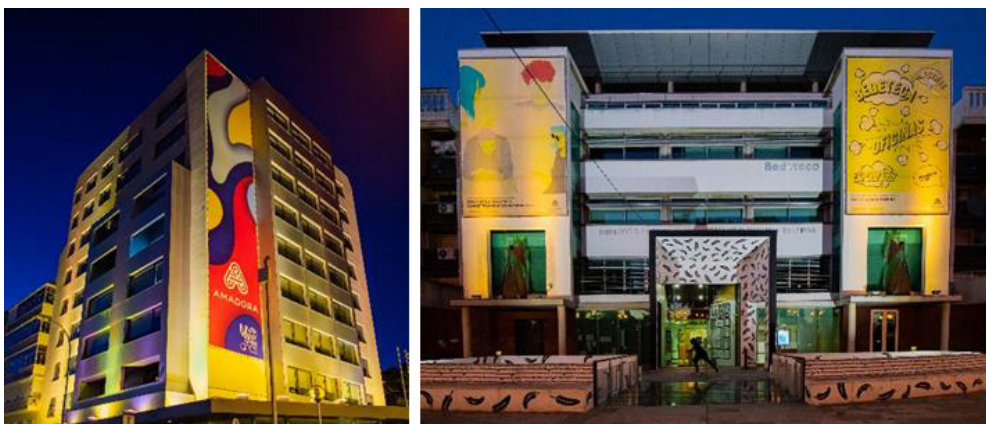
Figura 28. Iluminação de edifícios do Município da Amadora
